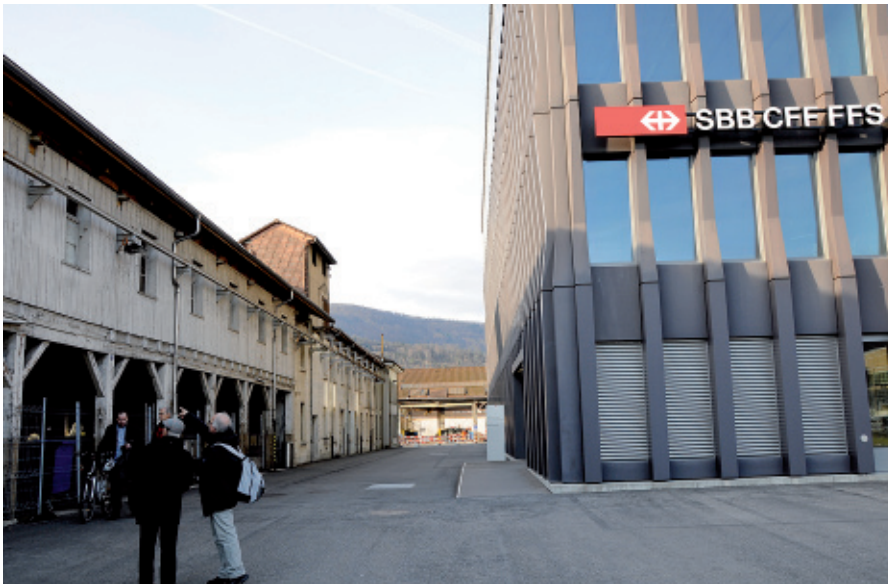
8956/59: Alt und Neu: Gleich neben dem Bahnhof Olten ist die neue Betriebszentrale Mitte angesiedelt. Links davon ein Relikt aus alten Zeiten: Die Werkstätte u. a. mit der Elektrik und einer Sattlerei für die Sitzüberzüge.
