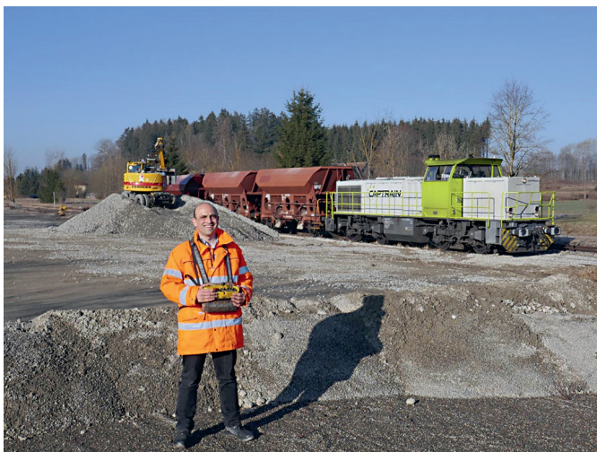
Einschotterung für den Freizeitbetrieb der neuen Biberbahn. Der Eisenbahnbetriebsleiter Frank von Meißner freut sich auf viele Fahrgäste.
