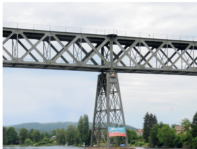
Mit 254 Meter überspannt dieses eindruckliche Zeugnis der Brückenbaukunst um 1875 den Rhein bei Hemishofen. Vorerst fahren nur historische Züge und Velodraisinen drüber. Foto: Johannes von Ark
